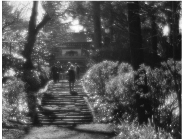
写真32 浄智寺参道の階段
